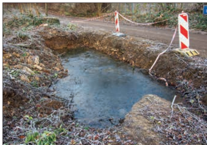
Bylo nutné odstranit „náletovky“ a pročistit vodoteč
